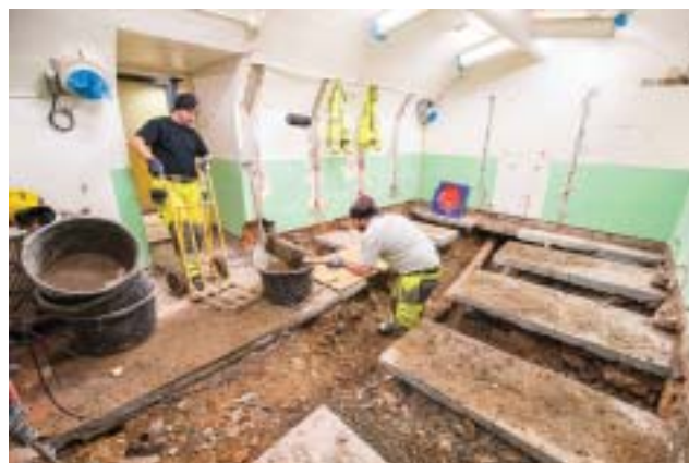
Omfattande renovering dusch
